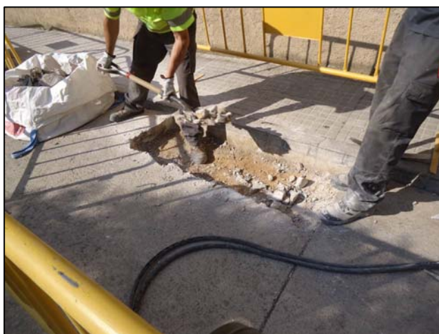
Imatge 3: Detall de l'obertura manual de la rasa al tram del camí del Castell.
