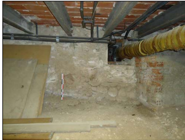
Imatge 7: Detall del tram de muralla documentat a la finca número 14 del carrer del Castell.
