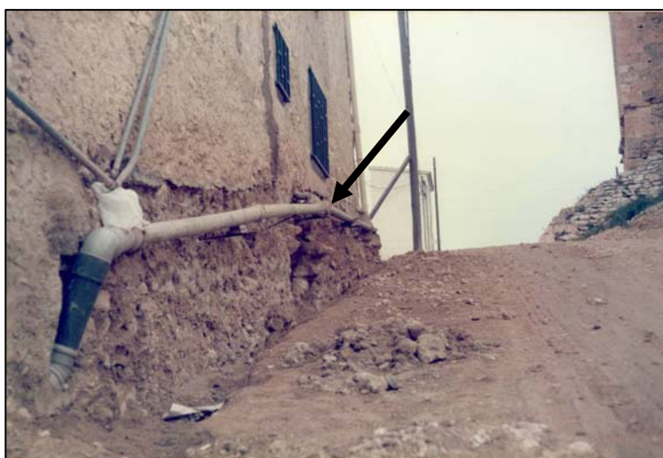
Imatge 6: Detall de les obres d'urbanització del camí del Castell durant els anys 80 del segle passat, on es pot veure l'afectació de la muralla sota la façana de l'edifici veí. Font: M a Teresa Lucas
