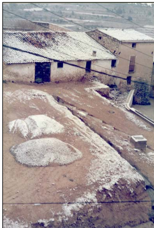
Imatge 13: Vista general dels treballs d'urbanització de la Plaça del Castell durant els anys 80 del segle passat. Font: M a Teresa Lucas.
