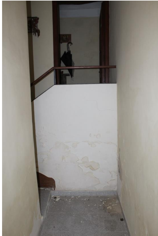
Fig. 05 Accés a l'habitatge.
