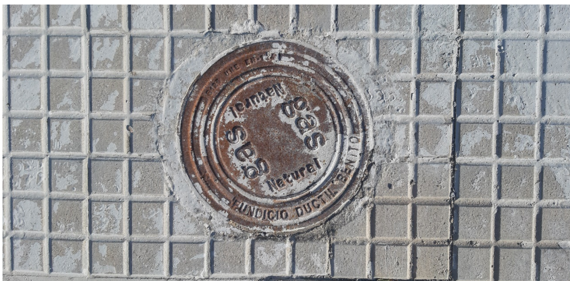
Fig. 43 i 44 Registre xarxa de subministrament de gas natural
