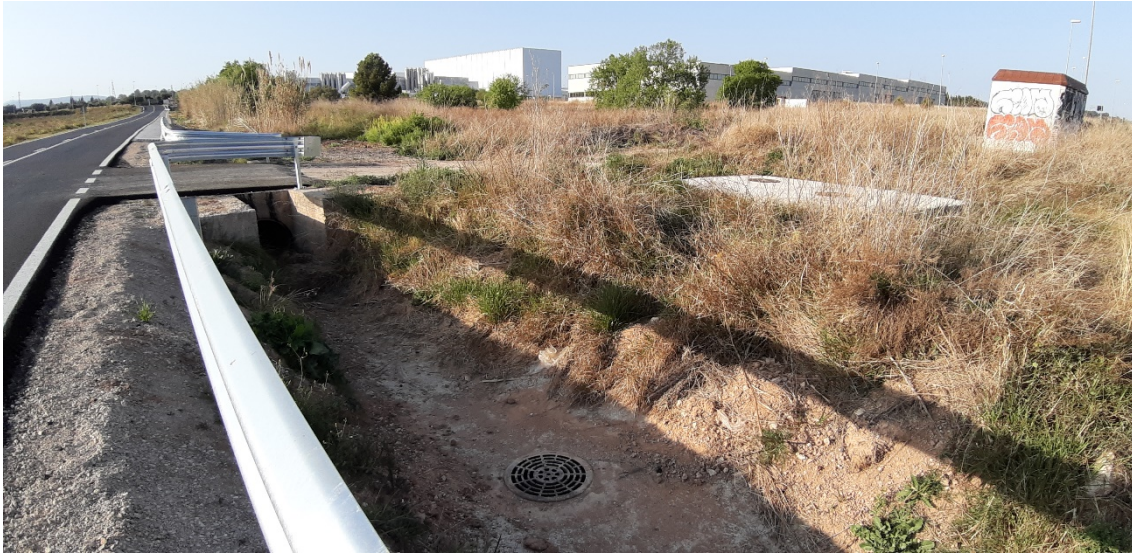
Fig. 34 Desguàs col·lector pluvials
