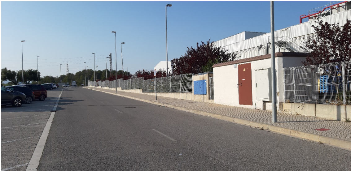
Fig.37 Enllumenat del carrer
