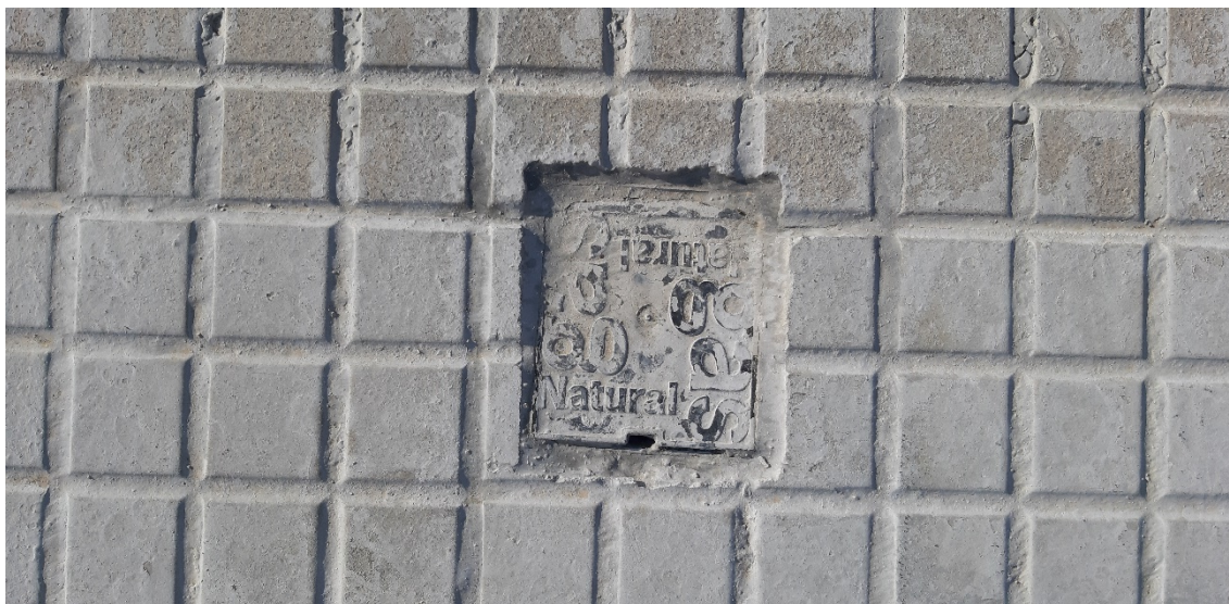
Fig. 45 Registres carrer xarxa de gas natural
