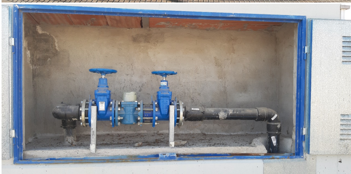
Fig.18, 19 i 20 Comptador d'aigua d'una de les empreses
