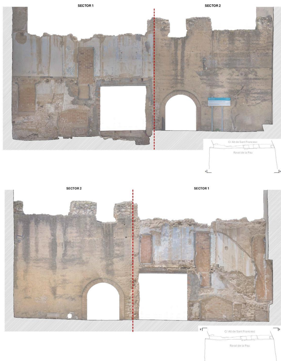
Figura 1. Ortofotografies general d'ambdós costats del tram de muralla on s'observa, separat per una línia vermella, les dues zones o sectors diferents.
