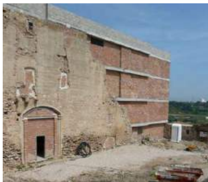
Edifici a mitger entre el pati principal i el pati d'armes, construït o reconstruït en època renaixentista
