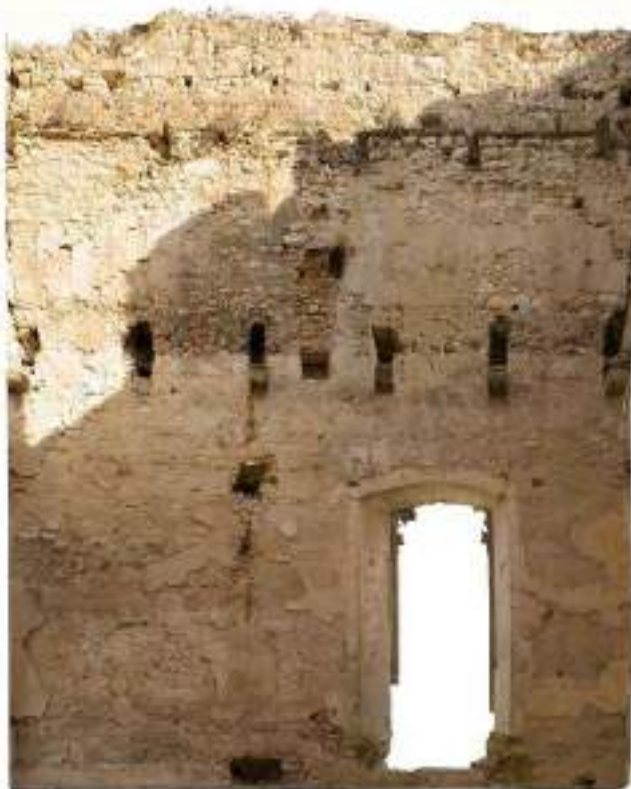
Mur nord de la torre principal. S'observen les mènsules que sostenien el sostre de fusta teginat
