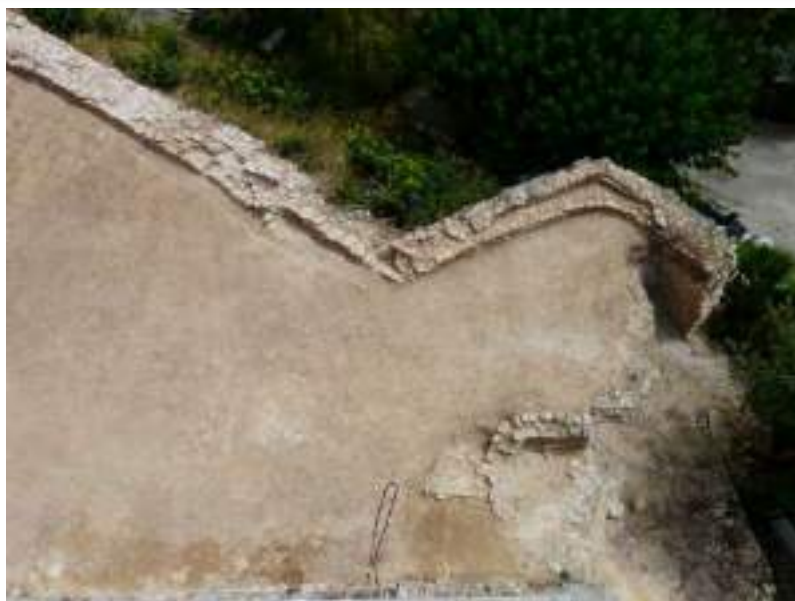
Baluard al sud-oest del pati d'armes i restes de l'entrada, construïts en època renaixentista
