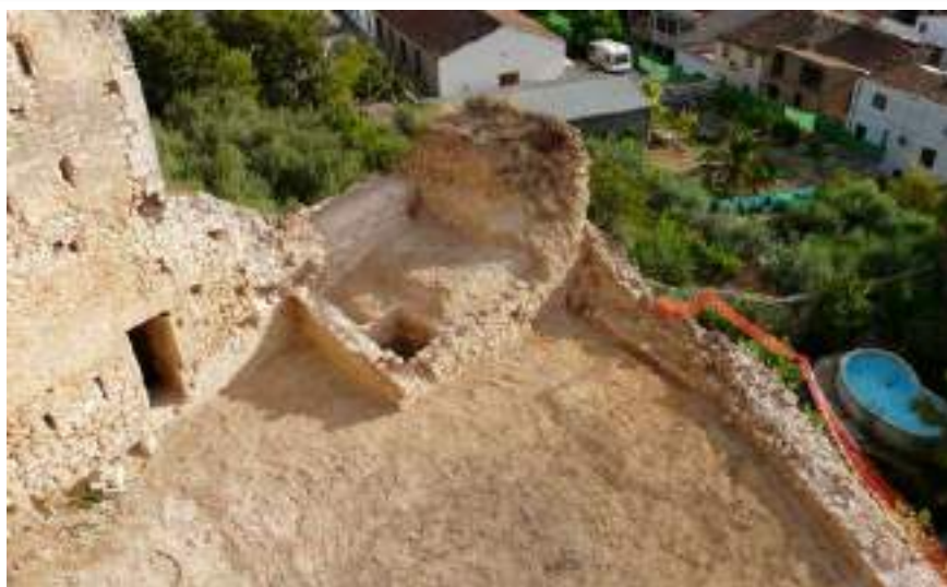
Restes de la torrassa construïda en època renaixentista a l'extrem nord-est del pati d'armes
