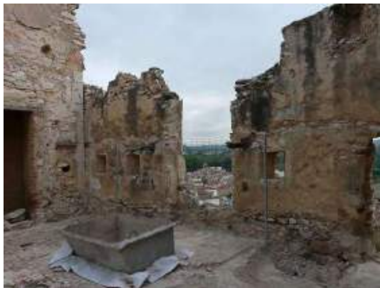
Mur de delimitació est de la sala noble construït a la fase dels segles XVII-XVIII
