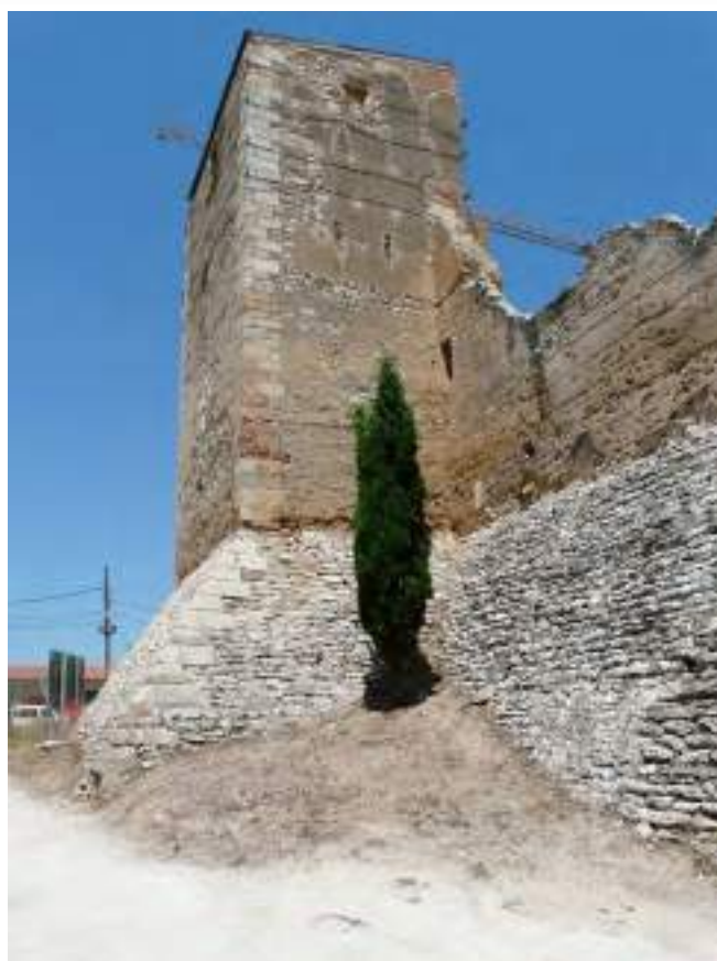
Muralla est i torre
