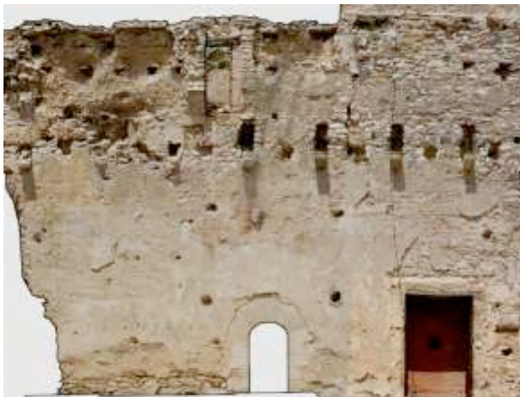
Mur nord de la sala noble. S'observen les mènsules que sostenien el sostre de fusta teginat.
