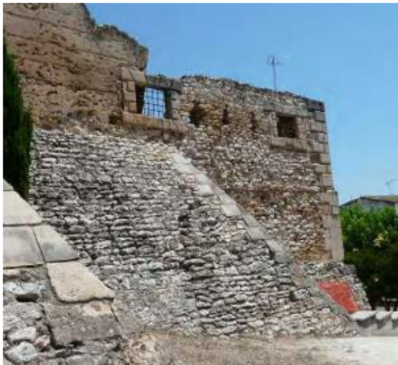
Tram sud-oest de la muralla corresponent a les reformes renaixentistes. Fase 4
