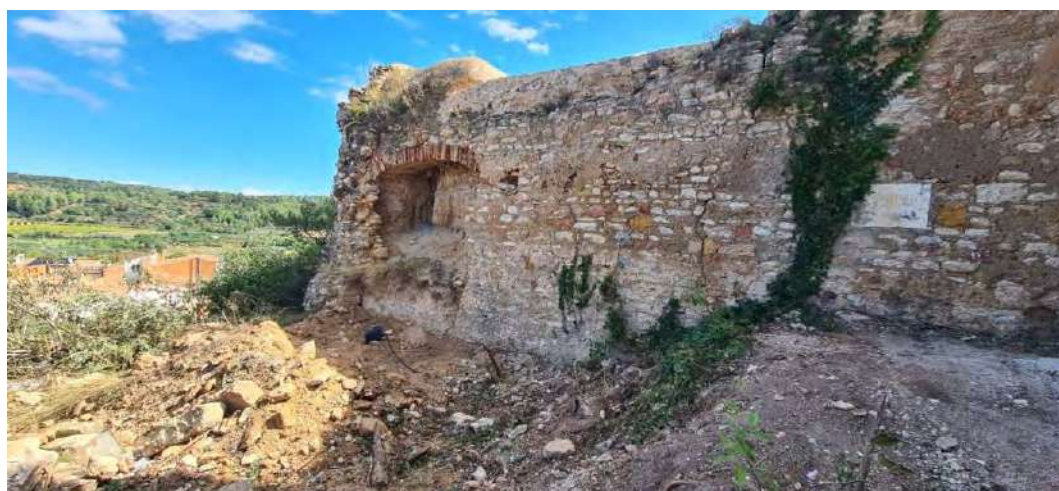
Vista de la zona d'actuació un cop extreta la vegetació.
