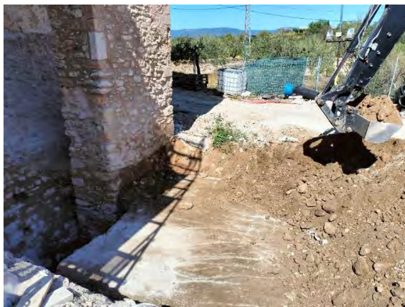
Vista inicial de la llosa de formigó.
