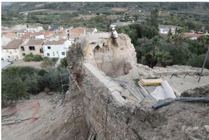
Vista de l'excavació en la part superior de la torrassa, banda est.
