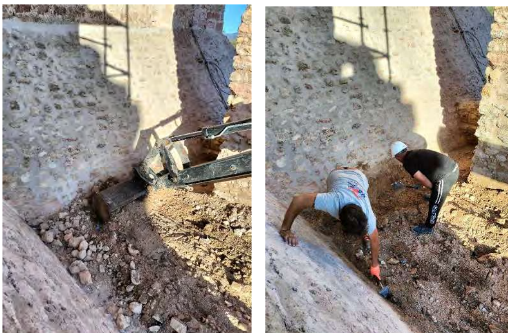
Vista dels treballs a màquina i manuals.
