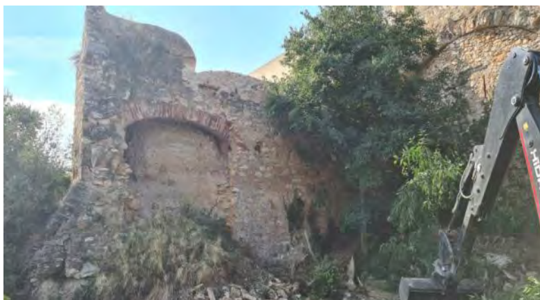
Vista de la cara nord de la torrassa durant les feines de sanejament de l'actual fase.
