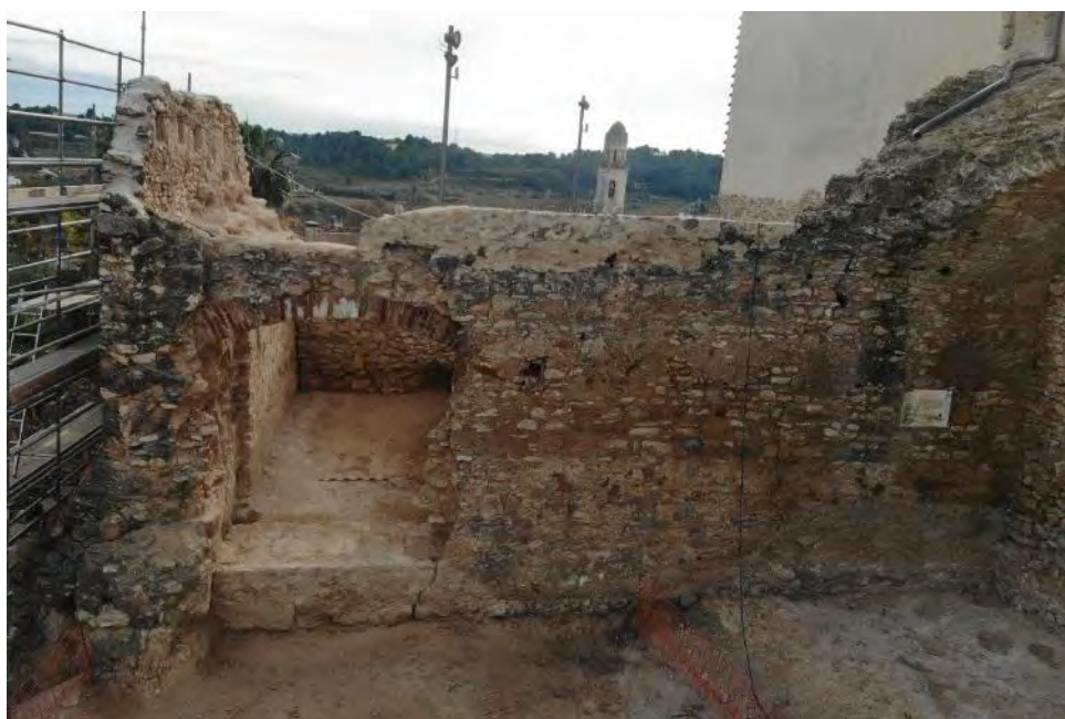
Vista general, banda nord de la torrassa un cop finalitzada la intervenció.
