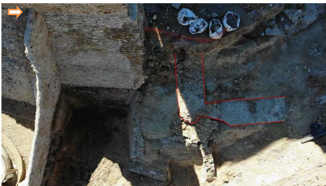
Vista en planta el conjunt d'estructures d'aqueta part del recinte, en vermell els murs U.E 210 i 211.
