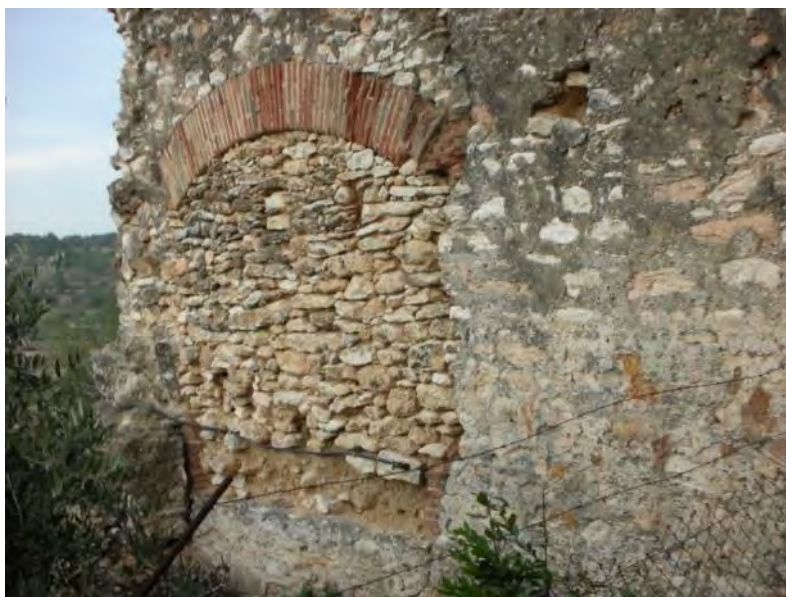
Vista de la cara nord, amb el tapiat U.E 62 l'any 2007. Fotografia: Miquel Orellana.
