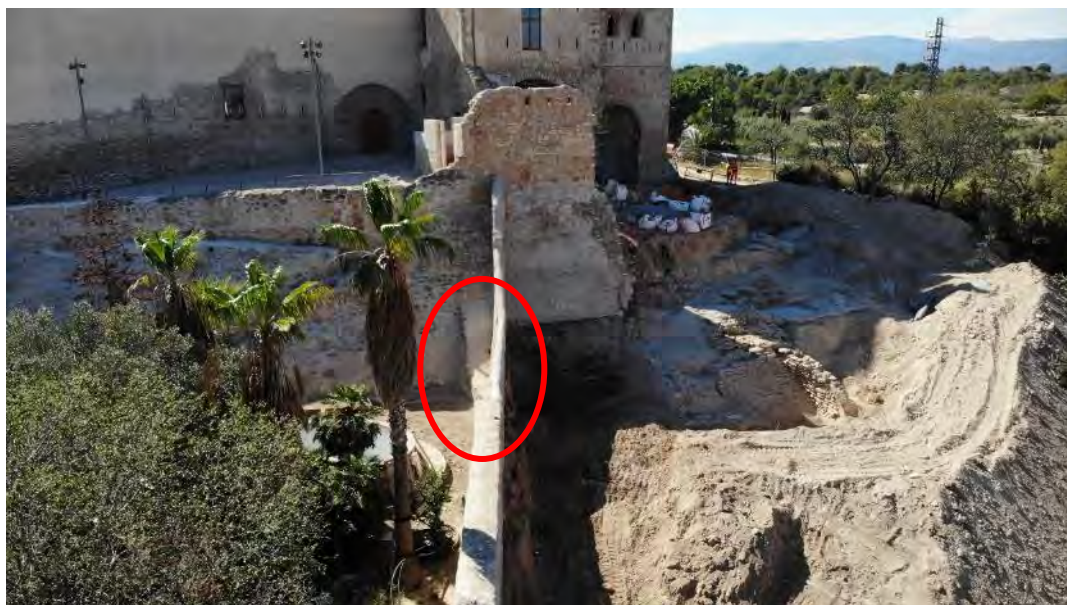
Vista del contrafort U.E. 224, per sobre el mur 219.
