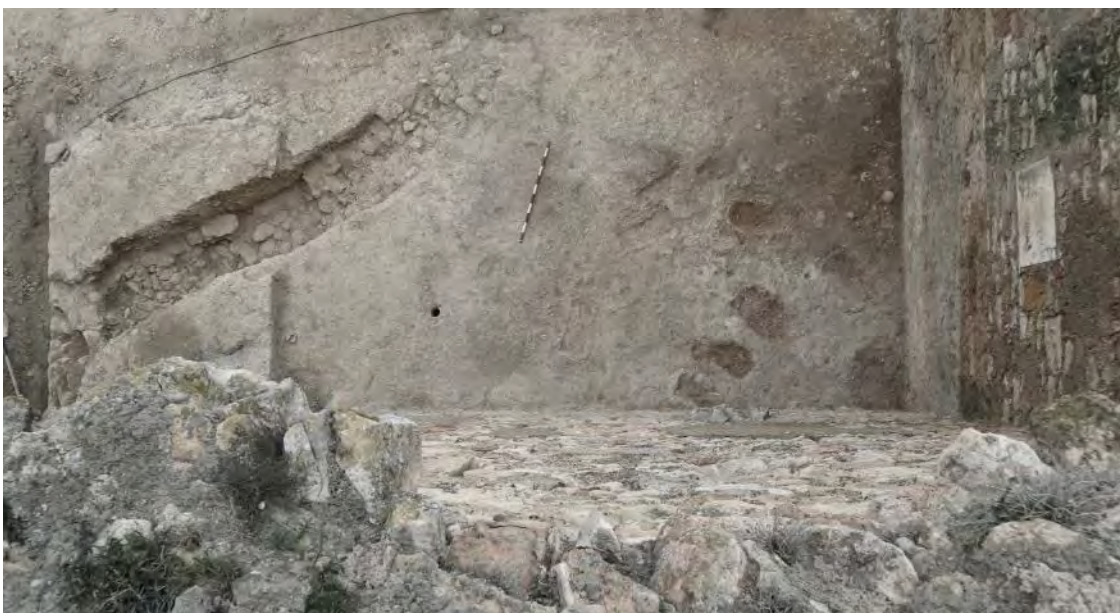
Vista final de l'excavació, de les negatives, la rasa, el paviment, la fonamentació del mur i el talús , juntament amb el forat d'un micropilotatge.
