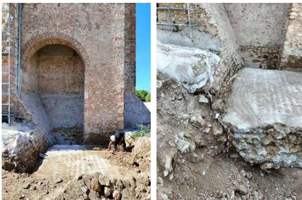
Vista final de la llosa un cop delimitada.
