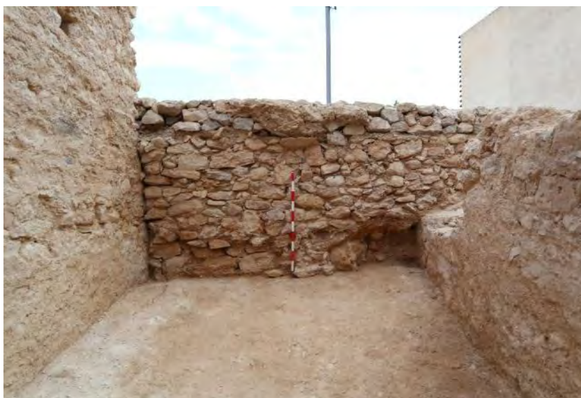
Vista del parament U.E 57, i del recrescut U.E 58 just a sobre. Es veu com el tapiat de la porta s'adossa a la muralla i fonamenta sobre el paviment U.E 47.
