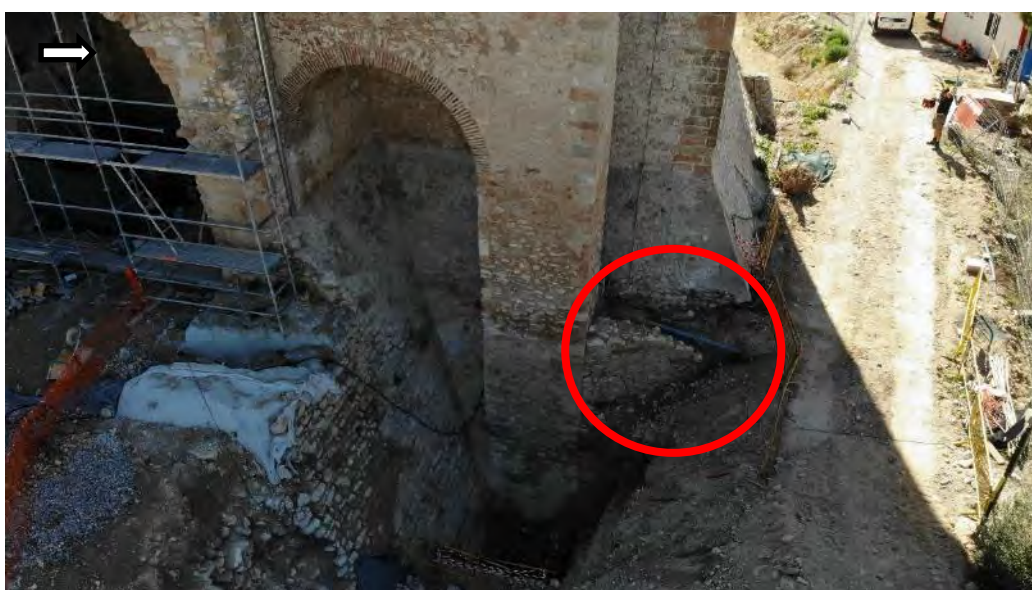
Vista general de la ubicació del mur 220.
