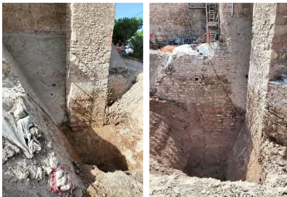
Vista del pilar de la torre de l'oratori fonamentat en l'escarpa.
