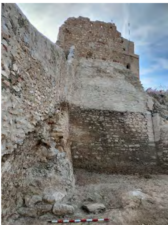
Vista en superfície l'estructura U.E. 225, al fons l'alçat complet del talús U.E 222.
