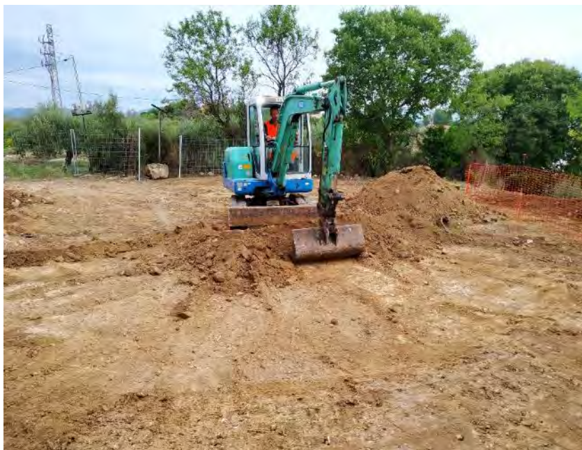
Vista de la màquina retirant el sediment superficial, i com ja s'observa el subsòl geològic.
