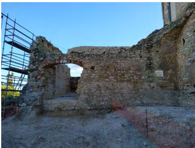
Vista frontal del parament intern meridional de la sala gòtica.
