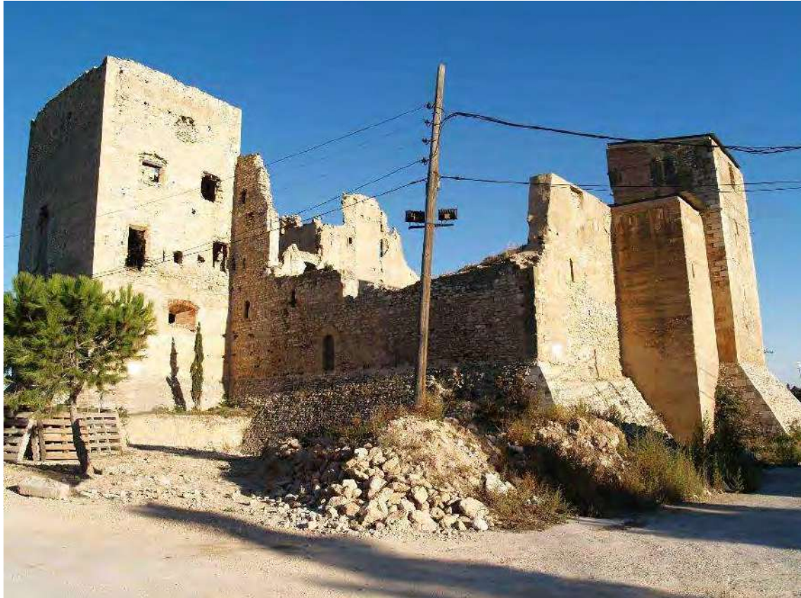
Imatge de la façana nord del castell, amb la porta primigènia i el talús del fossat construït posteriorment. Imatge: Miquel Orellana.
