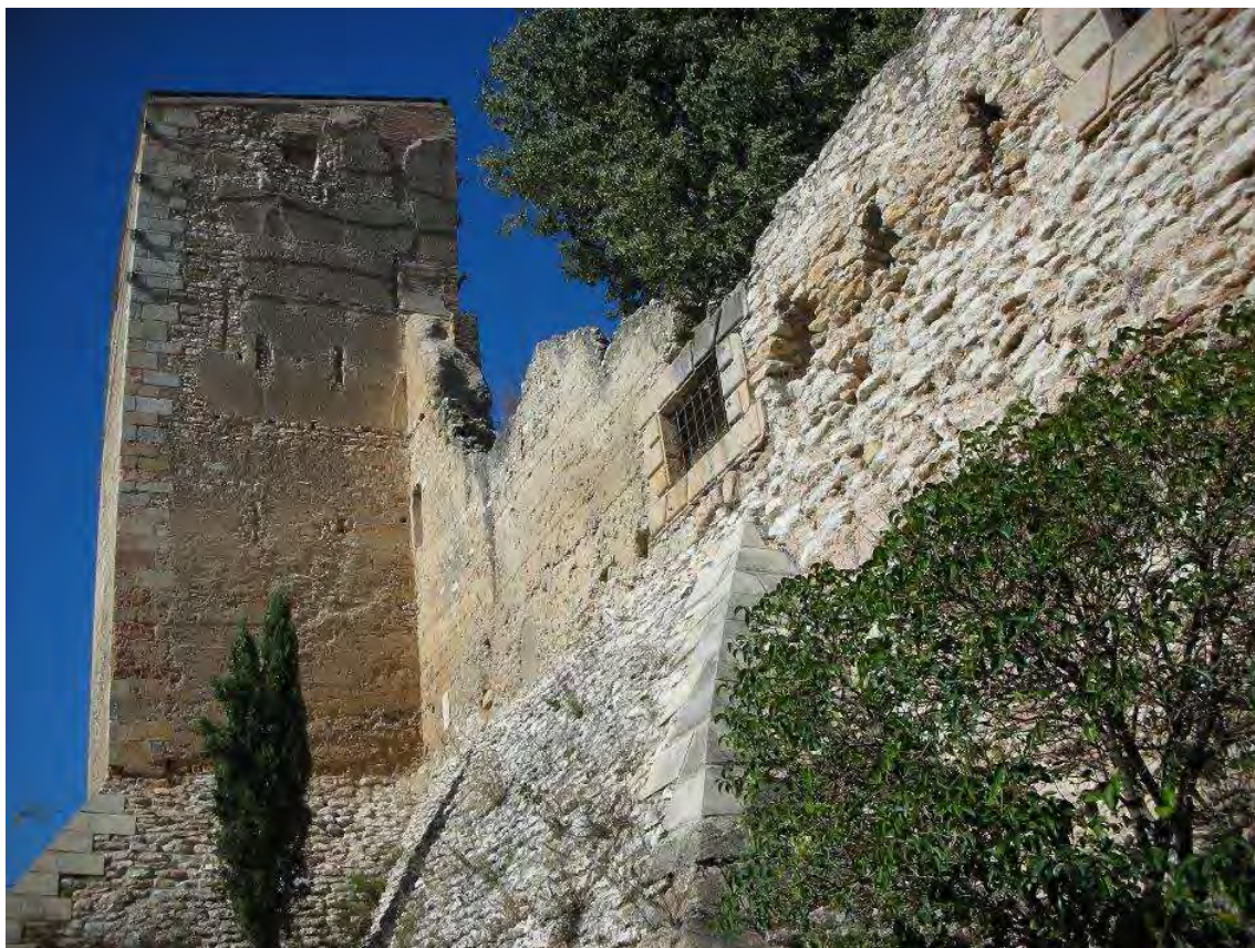
Imatge del canvi de factura constructiva en la façana nord-oest del Castell. Imatge: Miquel Orellana.
