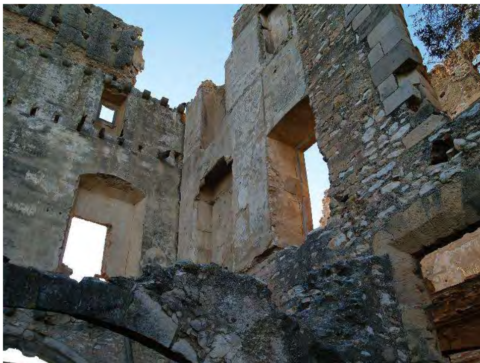
Imatge dels espais interiors de la sala gòtica del Castell, en el moment de l'aixecament de plànols. Imatge: Miquel Orellana.
