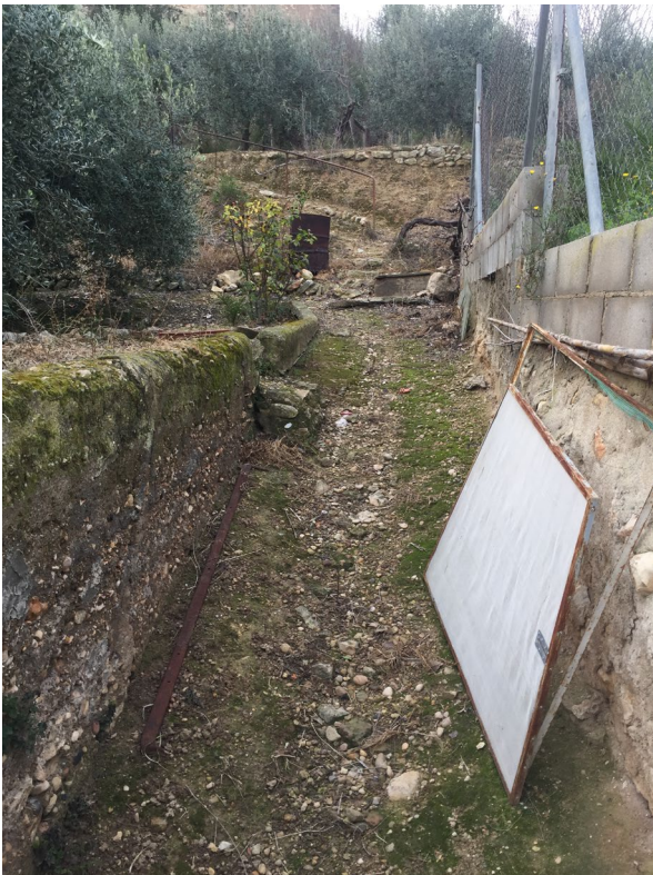
Rampa Nivell 1 - Nivell 2. Mur de pedra
