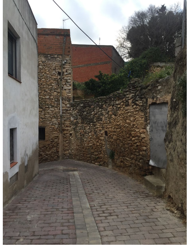
Vista de l'accés inferior. C. Ponent
