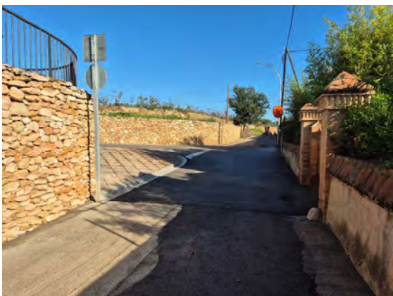
Inici zona a pavimentar a l'inici del camí
