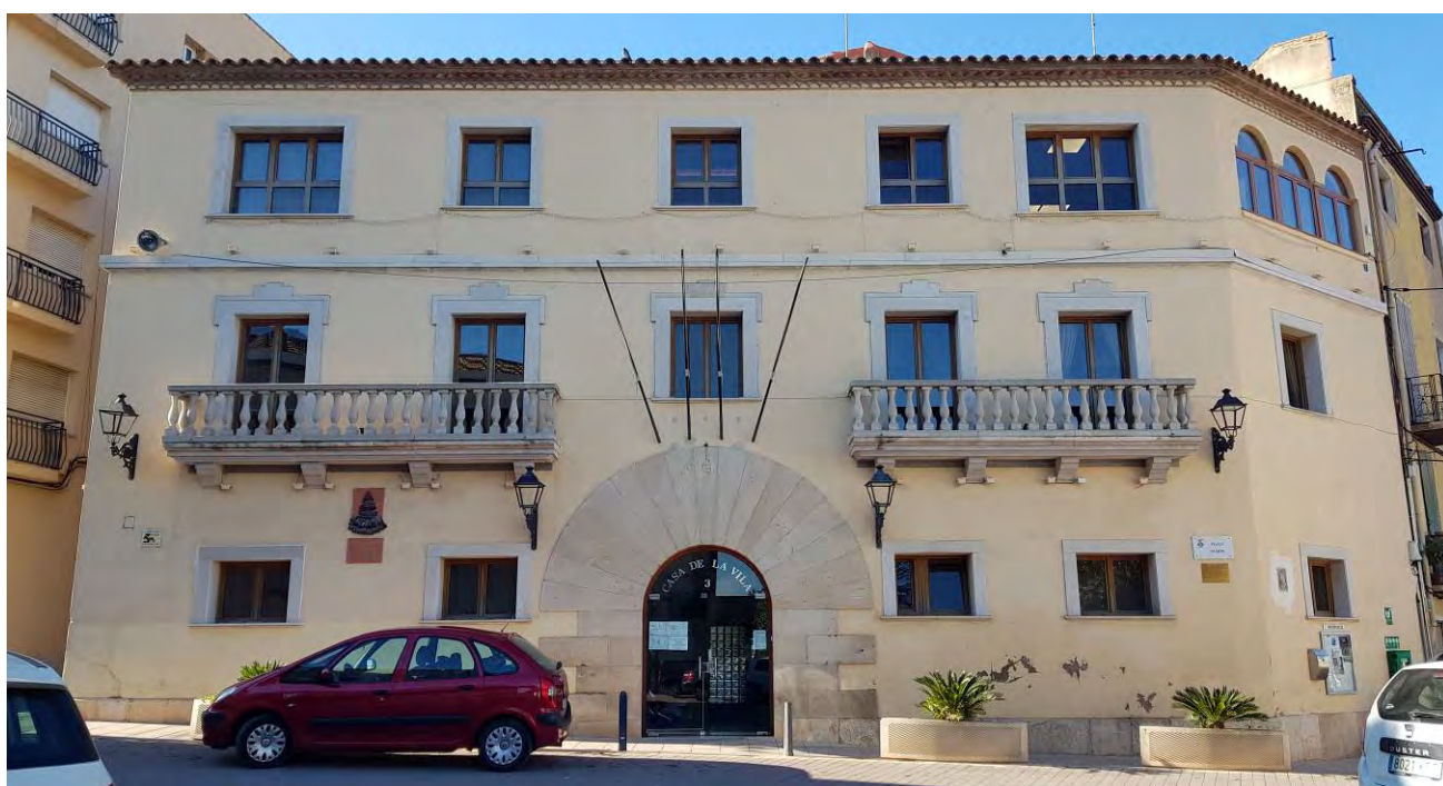
Façana principal sud-est
