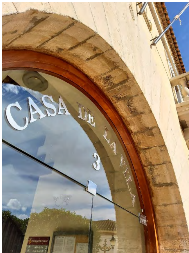
Imatge 3. degradacions presents en l'intradós de l'arc
